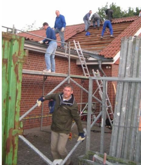
und neue Platten zu verlegen. Alle Übergänge wie First, Ortgang und der Anschluss an die Kehle wurden fachgerecht hergestellt und schon nach einer Woche erstrahlte unser Domizil in neuem Glanz.
