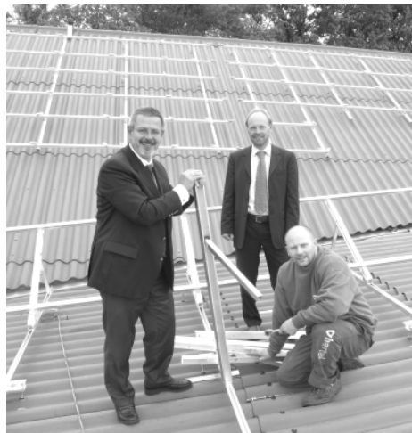
Die Kraft der Sonne: Fotovoltaik auf der Schützenhalle
